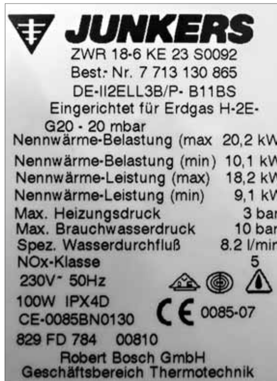
Das Geräte-Typenschild liefert wichtige Informationen für die Inbetriebnahme der Gasfeuerstätte
