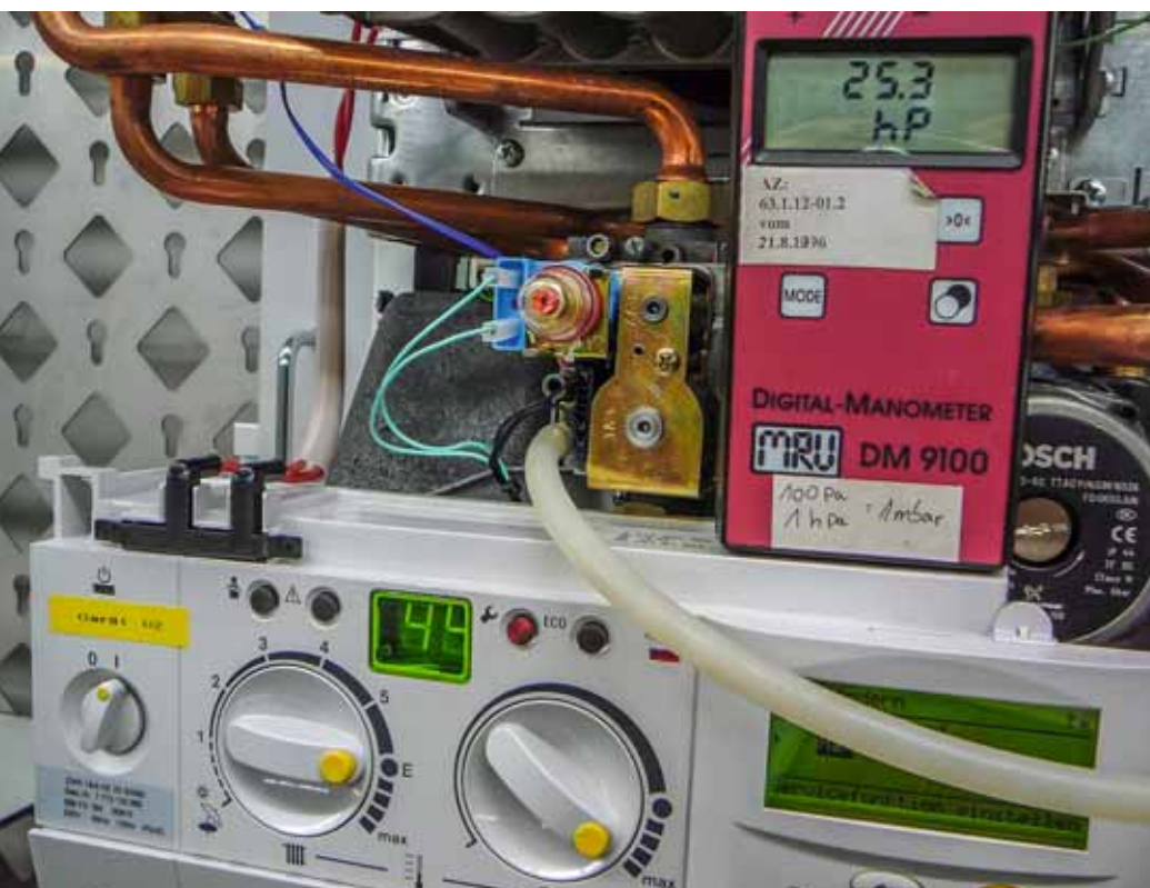
Die Düsendruckmethode verlangt eine Tabelle des Herstellers und ein Messgerät für den Druck
