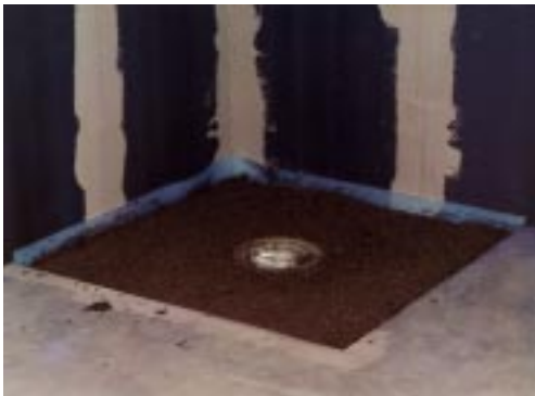
... wird der Duschbereich mit Mörtel verfüllt und verdichtet
