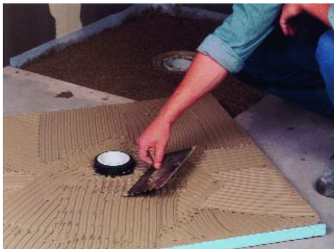
Die Bodenplatte mit montiertem Ablaufober- teil wird mit Fliesen- kleber be- strichen ...
