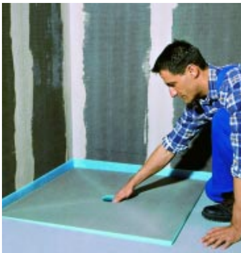
... und dann auf das Unterteil des Ablaufes im Mörtelbett aufgesetzt
