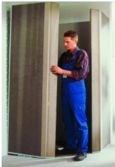
Die vormontierten Trennwände werden in die an Wand und Boden angebrachten U-Profile eingeschoben
