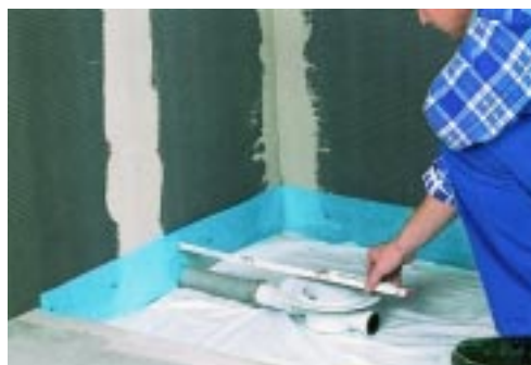
Nachdem der Bodenablauf installiert ist ...
