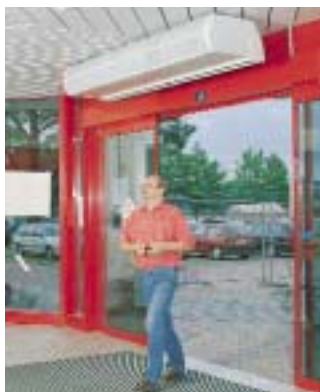
Luftschleieranlagen schaffen eine Abschirmung vor Kaltluftanfall an Toren oder Türen, die häufig geöffnet werden müssen
