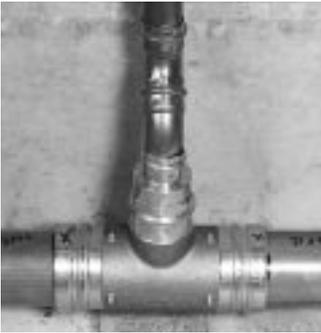
**Eine dichte Verpressung wird durch Markierung der Einbautiefen bei Montagebeginn sowie der Formstückmuffe nach dem Pressvorgang garantiert**
