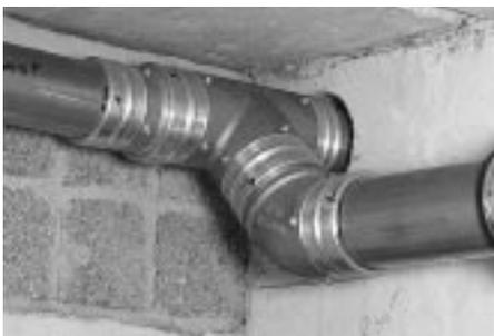
**Für eine Feuerlöschanlage wurden Kupferrohre mit Durchmessern DN 80 in Press-technik verlegt**
