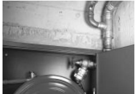
**Anschluss der Wandhydranten der Feuerlöschanlage**
